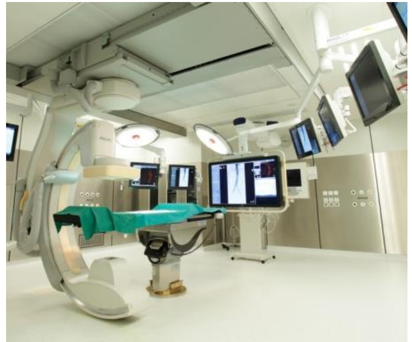
手術室等の設計施工
