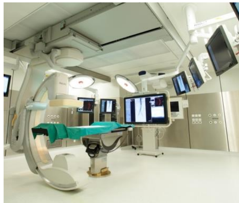
手術室等の設計施工
